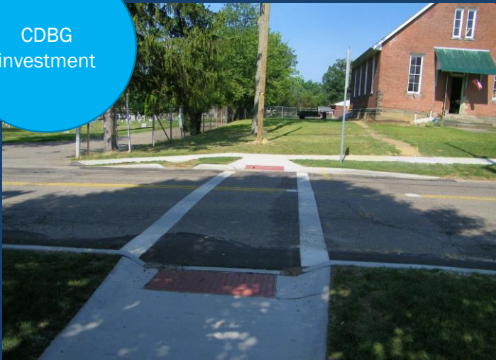
ADA curb ramp Perry Township
